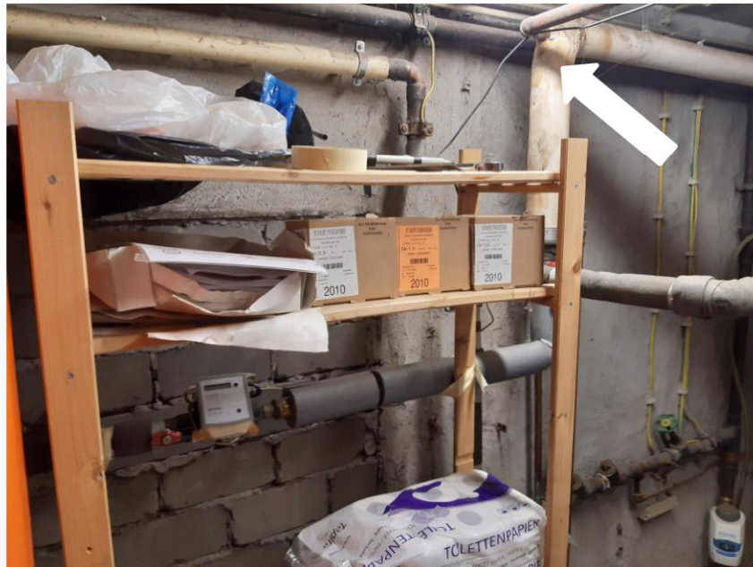
KMF-Isolierung der Rohrleitungen mit Gipsummantelung
