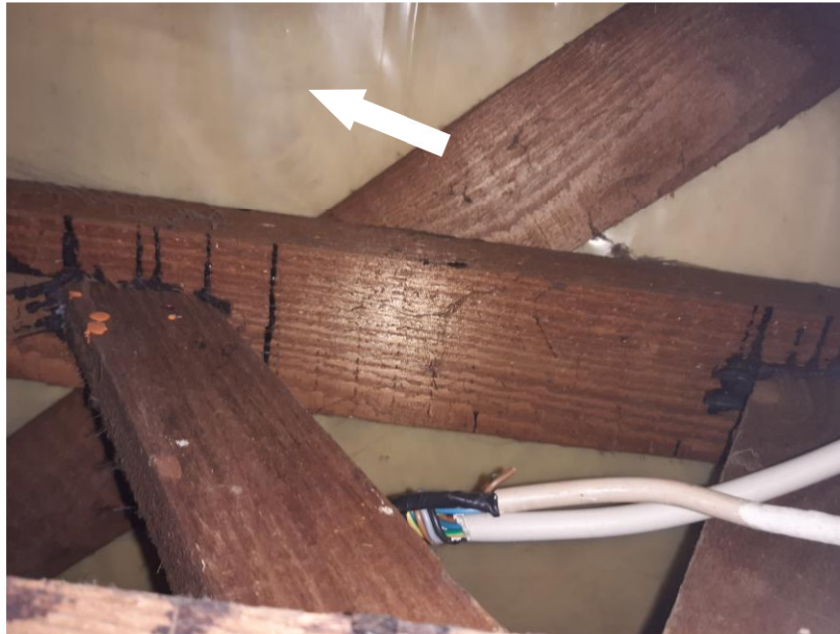
KMF-Dämmung in der Dachkonstruktion des Erkers
