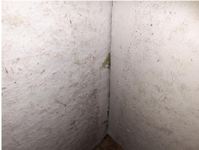
KMF-Dämmung hinter Prallschutzverkleidung in der Hockeyhalle
