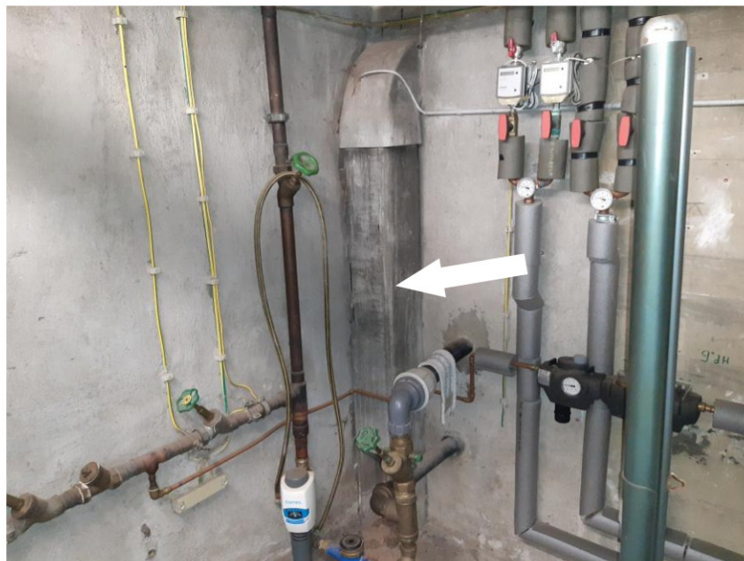
Asbestzementformteil Luftkanal Technikraum
