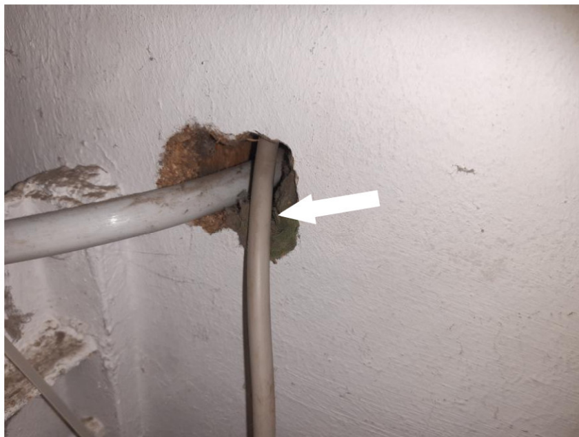
KMF-Dämmung in der Trennwand zwischen Tennis- und Hockeyhalle
