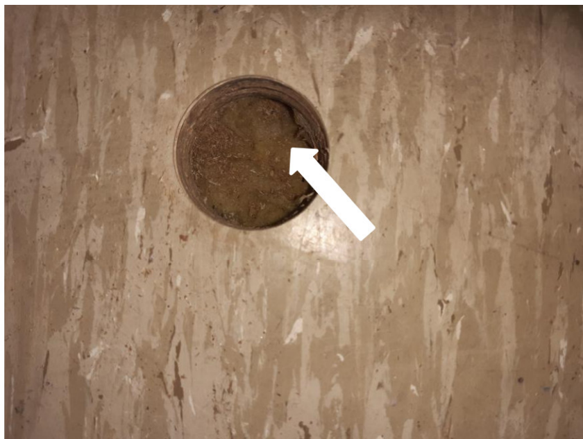
KMF-Dämmung unter Sportboden der Hockeyhalle
