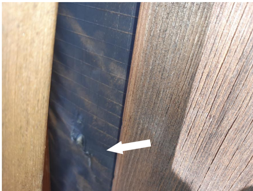
KMF-Dämmung hinter der Holzverkleidung des Erkers
